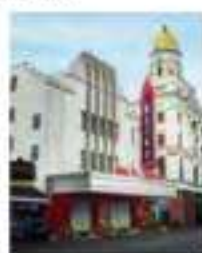
Metro/Central J - retrofitted
